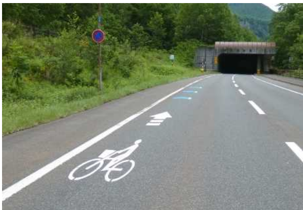
図-3 幅員狭小部の路面表示
