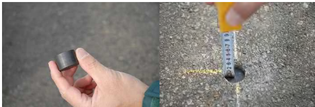
写真-4 磁気マーカ埋設状況
