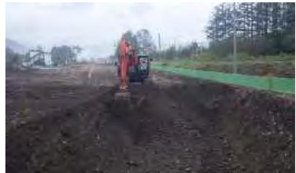
写真-2 MG技術（バックホウ）の施工状況
