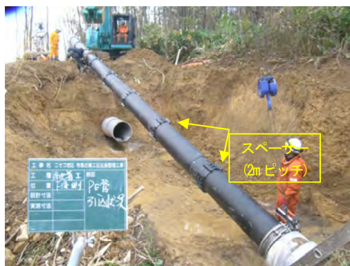
写真-1 PE管挿入状況
