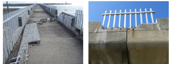
写真-2 立ち入り制限区間の老朽化状況 (A部)
