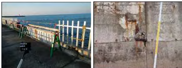
アルミ高欄の欠損状況
