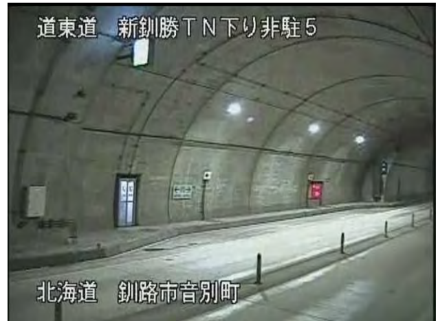
写真-4 非常駐車帯監視画像（清掃後）
