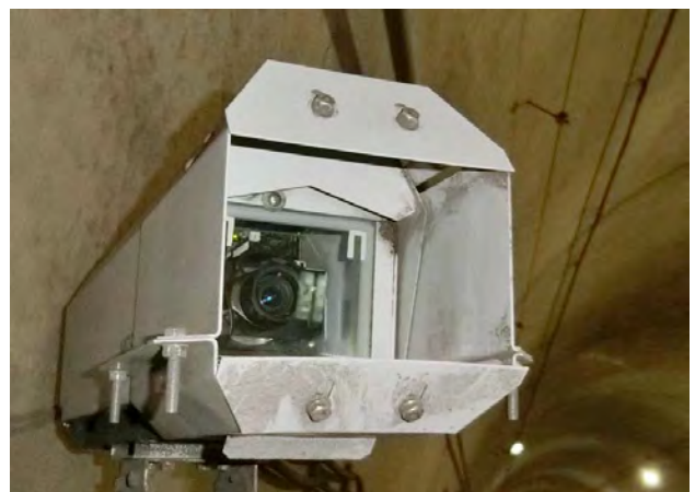
写真-9 フード取付状況
