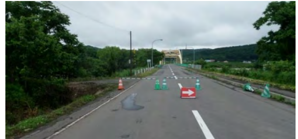
図-4 納内橋の通行止め（平成30年7月3日11時）
