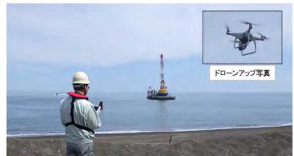
写真-7 ドローン操作状況
