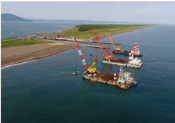
写真-9 サンドポケット浚渫状況①
