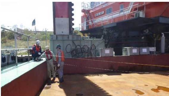
写真-5 積載部測量状況
