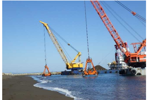
写真-10 サンドポケット浚渫状況②
