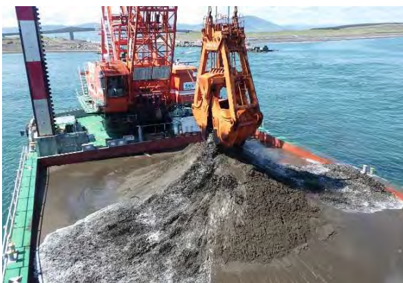
写真-11 浚渫土砂積込状況
