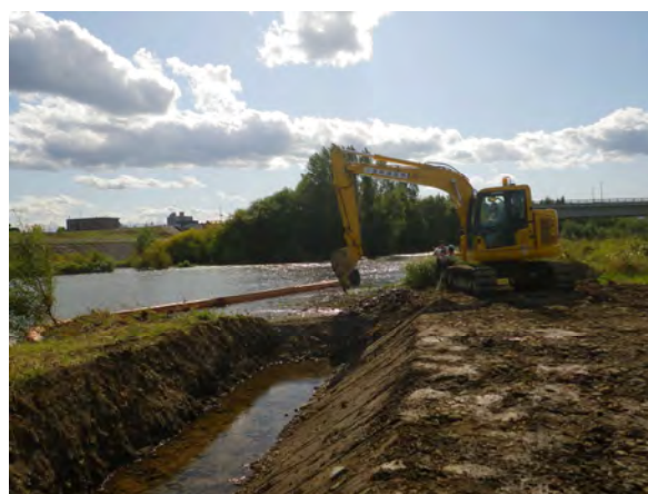
写真-2 alcove上流に堆積した砂州の掘削路造成作業 （施工最終日の2017年9月26日に本調査地の左岸砂州上から本流上流方向を撮影。）
