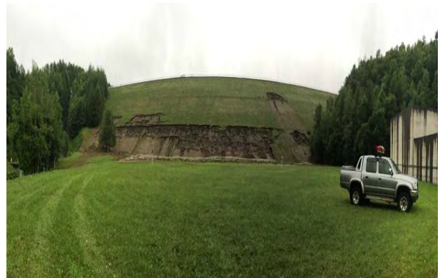
写真-2 しろがねダム堤体下流の流出状況(8月1日撮影)
