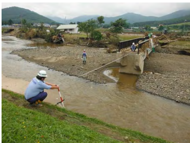
写真-5 橋梁の被災調査状況
