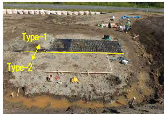
写真-2 基礎地盤対策工設置完了
