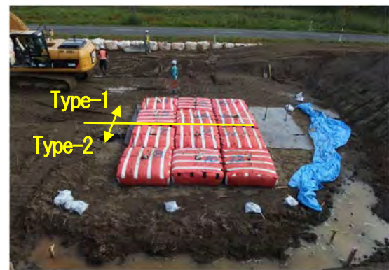
写真-3 荷重1段目 (D-BOX) 設置完了
