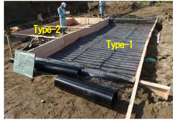
写真-1 補強材敷設状況
