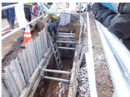
写真-5 掘削地盤内の出水状況
