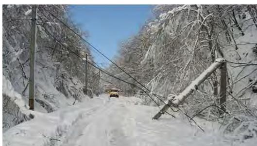
写真-3 暴風雪に伴う電柱の倒壊・電線の切断
