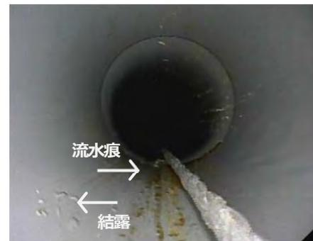
写真-3 管路継ぎ目部から水が流入したとみられる痕
