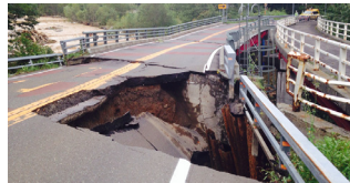
写-3 KP=33.4奥漁川橋
