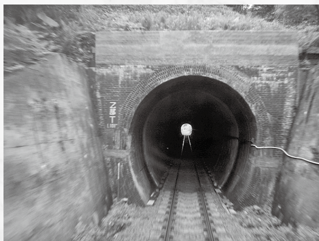
1903（明治36）年竣工で現役の根室本線乙部トンネル
