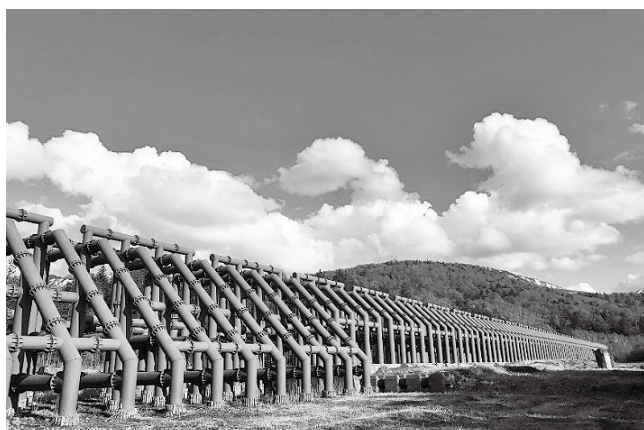
上富良野コースの富良野川第2号透過型堰堤
