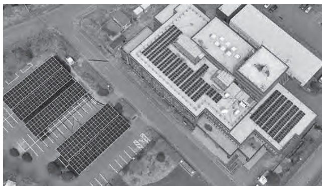
役場庁舎の太陽光パネル
