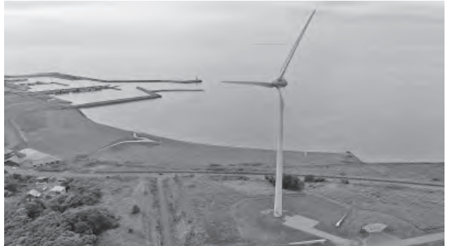
苫前夕陽ヶ丘風力発電所
