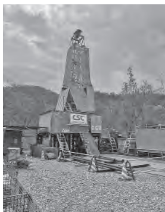
令和4年二酸化炭素埋め戻し実験に向けたボーリング作業の様子
