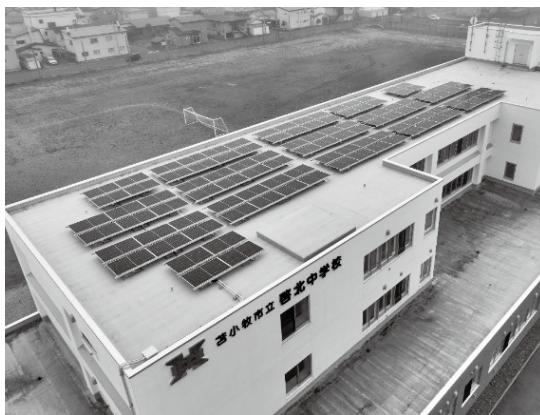
苫小牧市立啓北中学校への太陽光パネル設置
