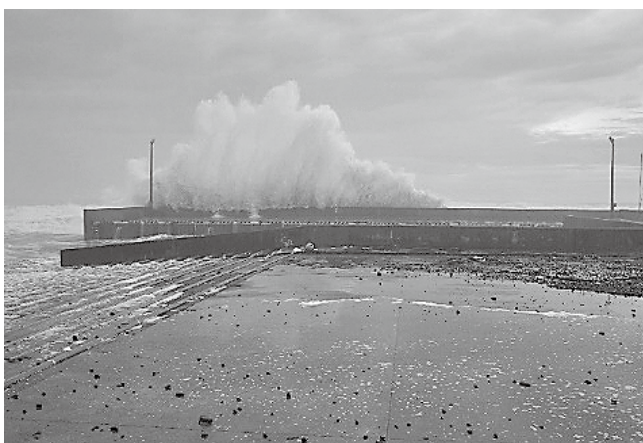
静穏度対策（防波堤の嵩上げ）
