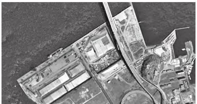
室蘭港整備箇所
