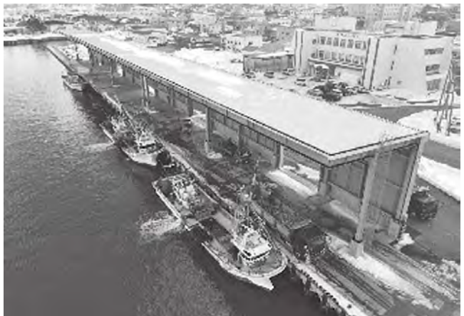
紋別港 屋根付き岸壁(令和4年10月供用)(5棟目)
