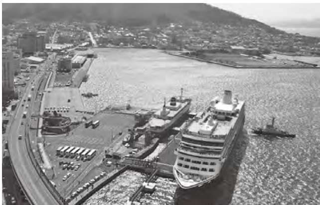
既設岸壁を活用した受入環境整備（函館港）
