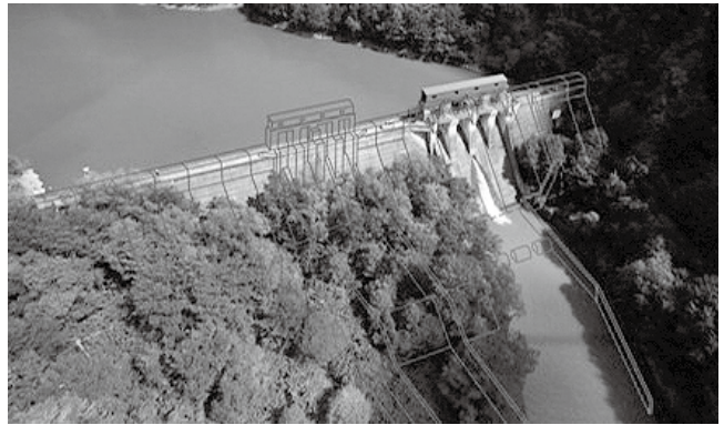
雨竜第2ダム（堤体嵩上げ・容量振替）
