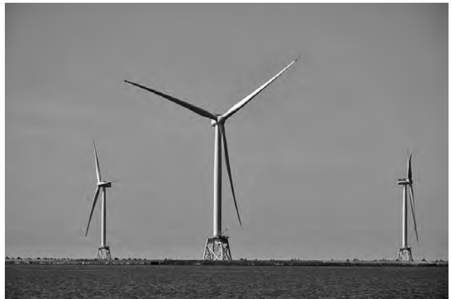
写真1 2024年に営業運転を始めた石狩湾新港洋上風力発電所
