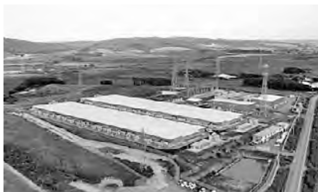
写真) 北海道北部風力送電(株)の国内最大規模のリチウム蓄電池システム。総事業費は約1,050億円（経済産業省資源エネルギー庁「風力発電のための送電網整備等の実証事業」の対象事業）で、風力発電専用の設備。
