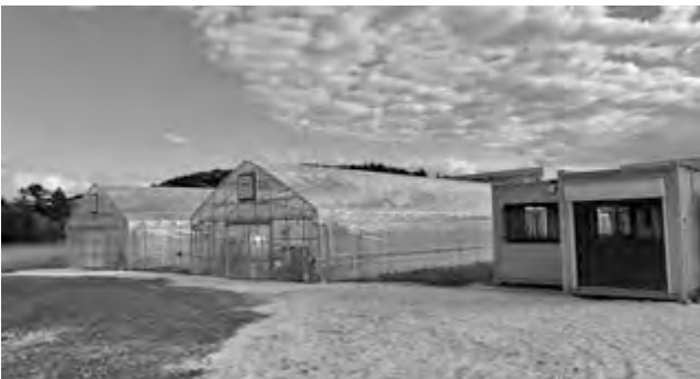
2020年9月に完成した2棟のビニールハウスと休憩所
