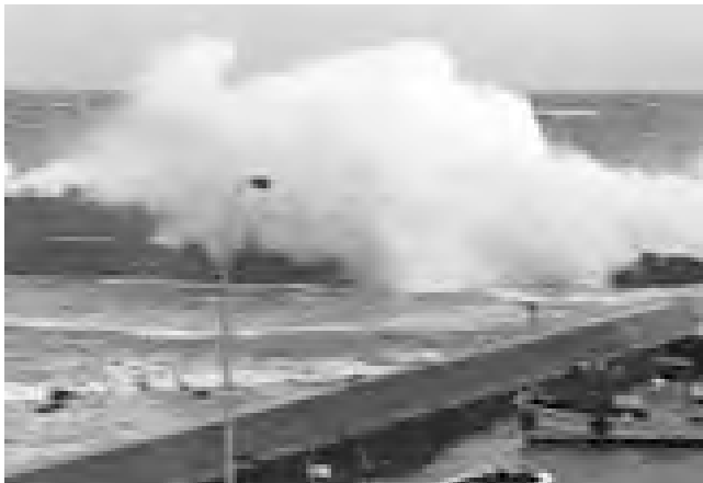
静穏度対策（防波堤の嵩上げ）
