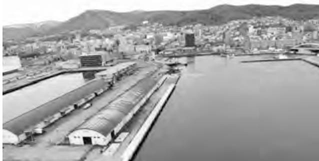
小樽港クルーズ船岸壁整備状況(令和3年5月)
