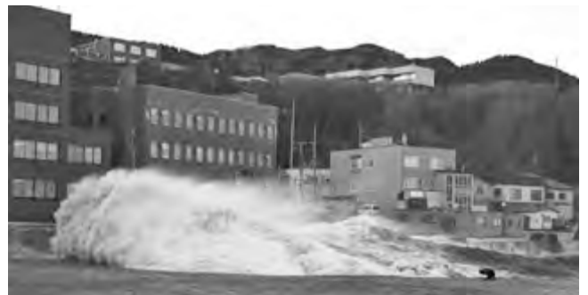
荒天時の越波等による港内擾乱状況（香深港）
