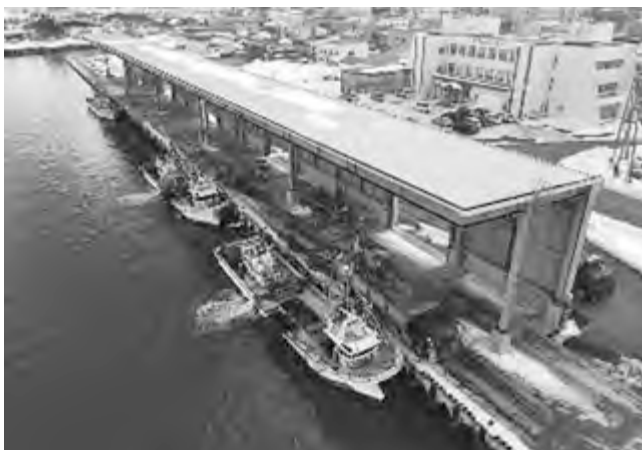
紋別港 屋根付き岸壁(令和4年10月供用)(5棟目)
