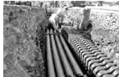
浅層埋設、角型多条電線管の施工 (七飯町 国道5号)
