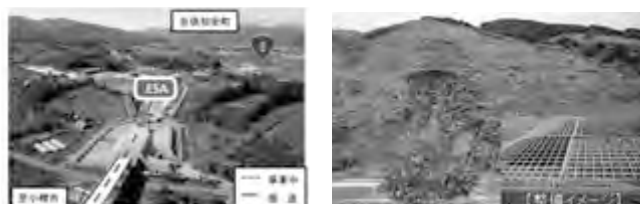
災害に強い国土幹線道路ネットワークの機能強化 (北海道横断自動車道(国道5号) 倶知安余市道路) 道路法面・盛土の土砂災害防止対策 (国道232号 苫前町力屋地区)
