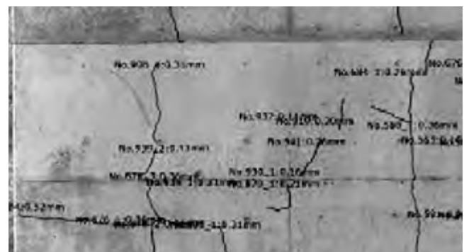
ドローン撮影画像から損傷図を作成
