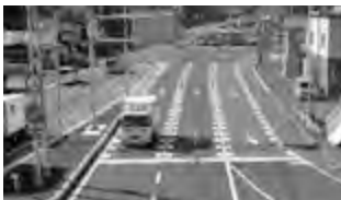
カラー舗装による車線の明確化 (国道36号 登別市)
