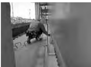
施設の点検（水門ゲート設備）
