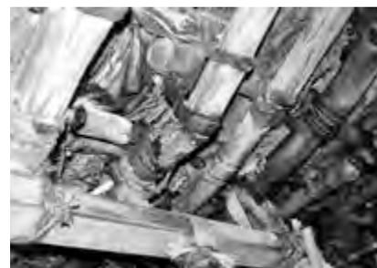
写真8 富山県北代縄文広場の復原住居でみられた垂木材の腐朽状態（富山市教育委員会2017）
