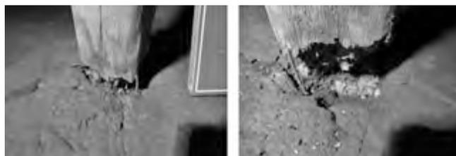
写真7 富山県北代縄文広場の復原住居でみられた柱材の腐朽状態（富山市教育委員会2017）
