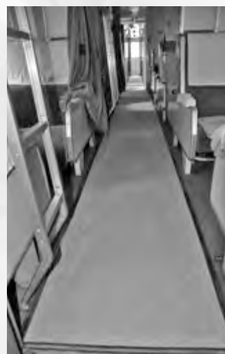
車両通路床張替え
