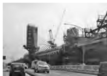
ケラニ河新橋建設事業
