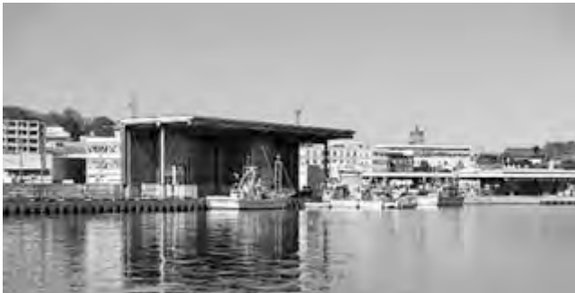
紋別港 屋根付き岸壁(令和元年10月暫定供用)
