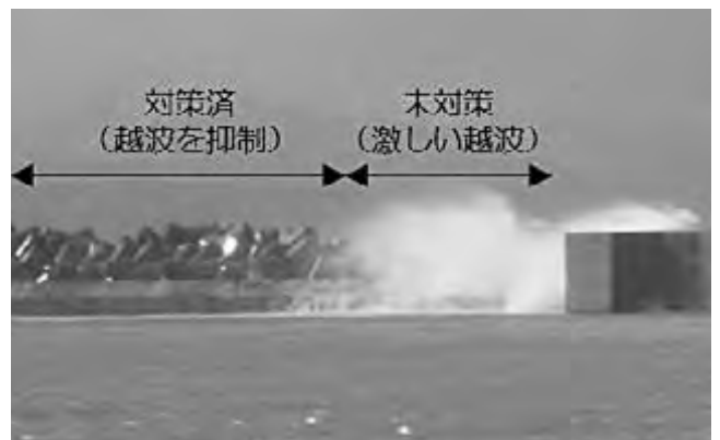
消波ブロック嵩上げによる越波抑制効果例
