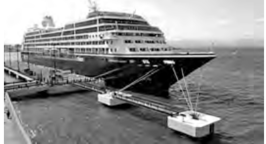
函館港クルーズ船接岸状況(平成31年4月)(水深8m暫定供用)
