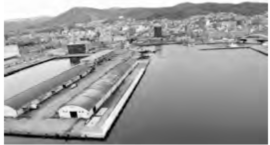
小樽港クルーズ船岸壁整備状況(令和3年5月)
