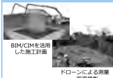
BIM/CIMを活用した施工計画 ドローンによる測量・写真撮影
