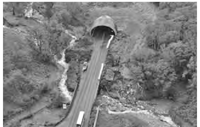
写真-2 トンネル内部の土砂を撤去（通行止め解除）
