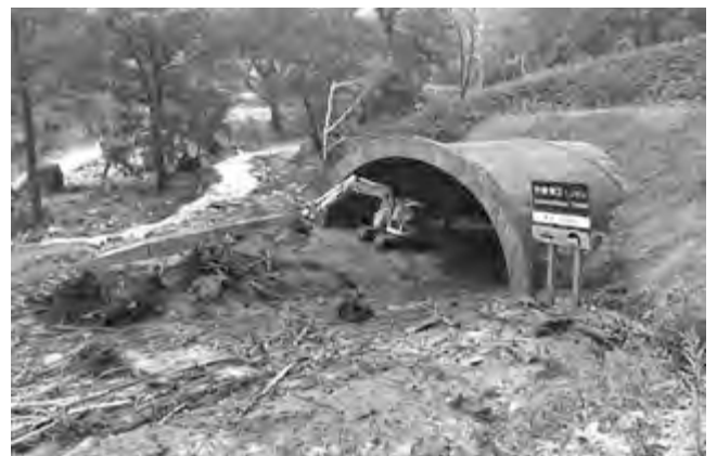
写真-1 狩勝第二トンネル付近の被災状況
