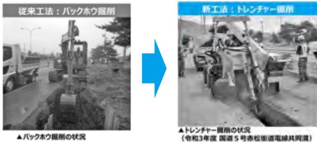
図13 北海道における無電柱化低コスト技術の取組（トレンチャー掘削機）
