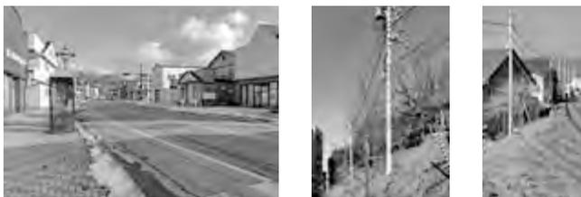
裏配線による無電柱化(浦河町 国道235号)
