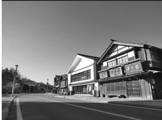
江差市街地・かもめ島と（上）と江差の町並み（日本遺産ポータルサイトより引用）
