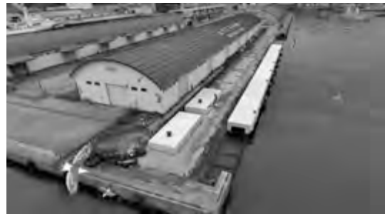
小樽港クルーズ船岸壁整備状況（平成30年7月）
