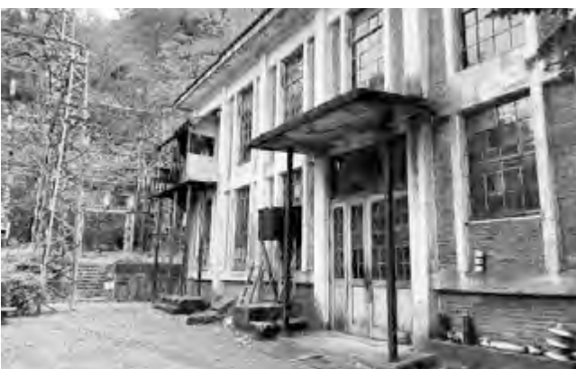
旧幌内炭鉱変電所
