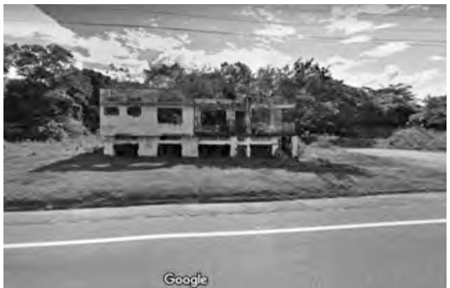
図10 泥流に埋まったアルメロ市街地の扇中央部。開通した国道沿いにあるこの建物は1階が半ば埋没している。（2019. 7撮影のGoogle Earth Street View）
