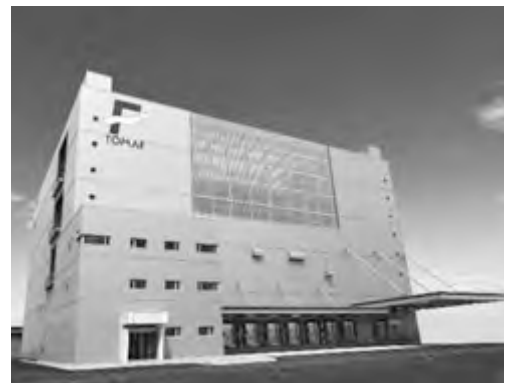
苫小牧埠頭(株)の運営する温度管理型冷凍冷蔵施設「北海道クールロジスティクスプレイス」
