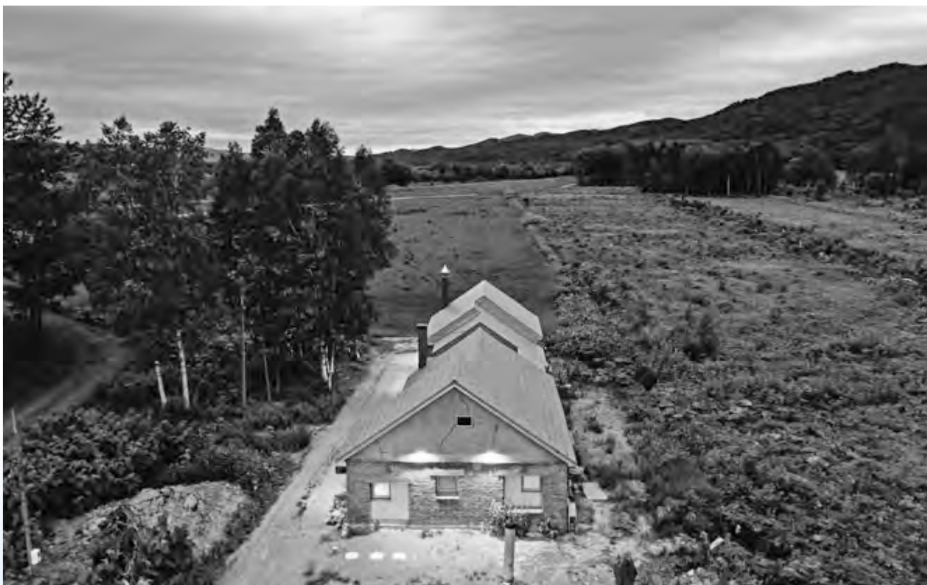
築70年ほどの2棟続きの廃屋を改装した「青い星通信社」。写真右手には宗谷本線の線路が延びている
