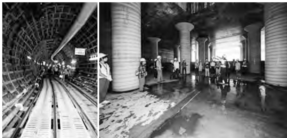
放水路トンネル
