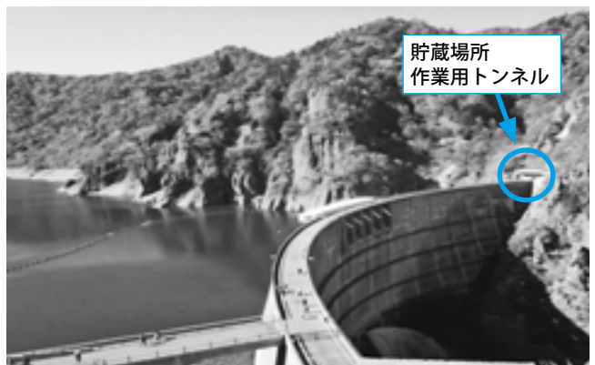
図6 ダム建設中に掘られた長さ約50mのトンネルに貯蔵（豊平峡ダム。札幌市南区）
