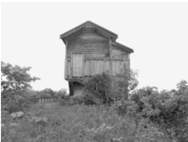
横から見ると、木造の上屋がツリーハウスのようにも見える。上屋の中には門扉を上下させるための巻揚機が格納されている。
