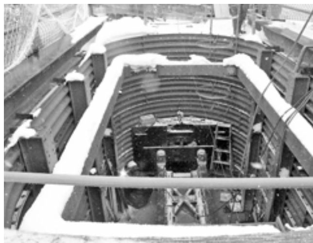
導水路工事では、地下の作業も多い
