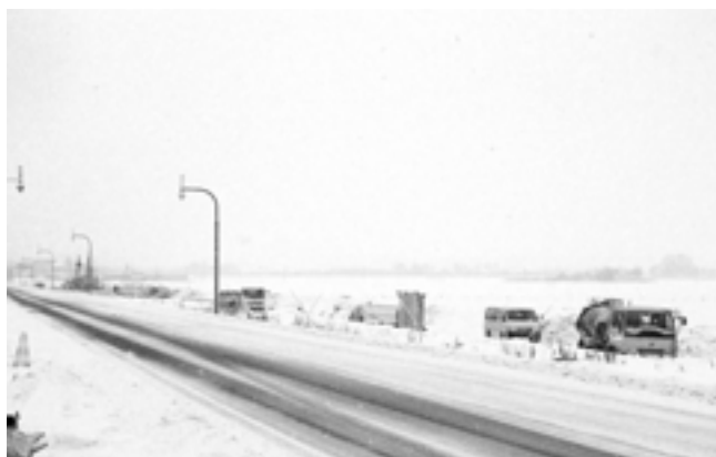
雪の中工事が進む厚幌導水路宇隆工区
