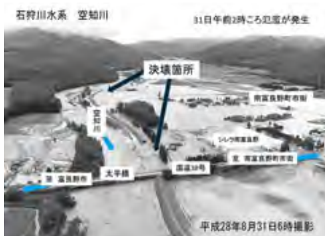
南富良野町の被災状況（北海道開発局提供）
