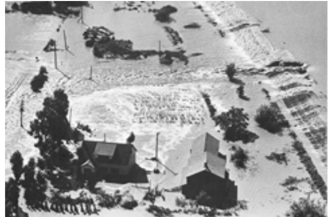
昭和50年美唄市大曲左岸築堤の越水破堤 (読売新聞社提供)
