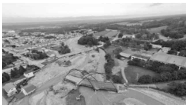
清水町ベケレベツ川の被災状況（北海道河川財団提供）
