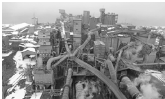
太平洋セメント上磯工場：セメント施設を利用して自動車シュレッダーダストを処理する手法が近年増加している
