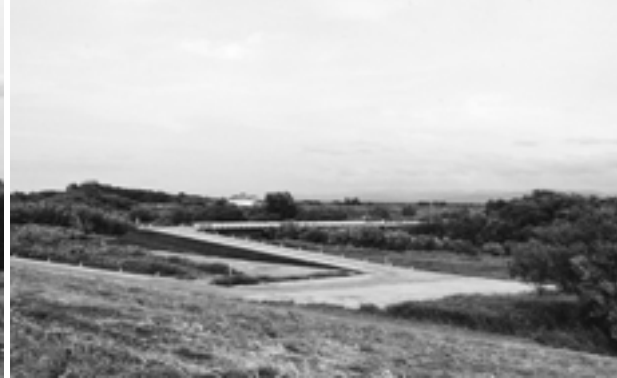
掘削した土砂を運ぶための仮道路
