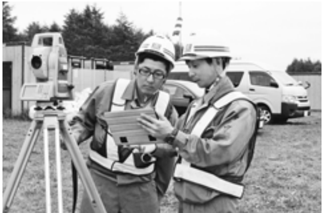
光波測距儀で測量した値をタブレットで確認する山田さんと山田さん
